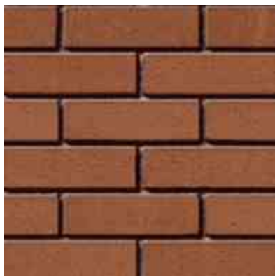
Imagen 62: Muro de tabique
