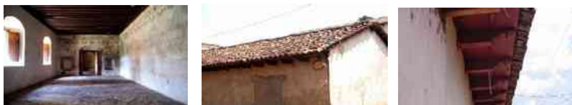
IMAGEN. Techos de teja y viguería, de viviendas en la Region de Tzintzuntzan. 38
