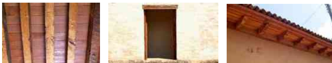
IMAGEN. Detalles de vigas de madera en techos y vanos. 37
