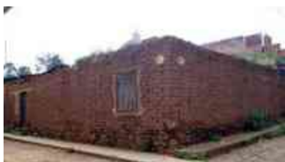
IMAGEN. Muros de mampostería de piedra y adobes, en la región de Tzintzuntzan. 36
