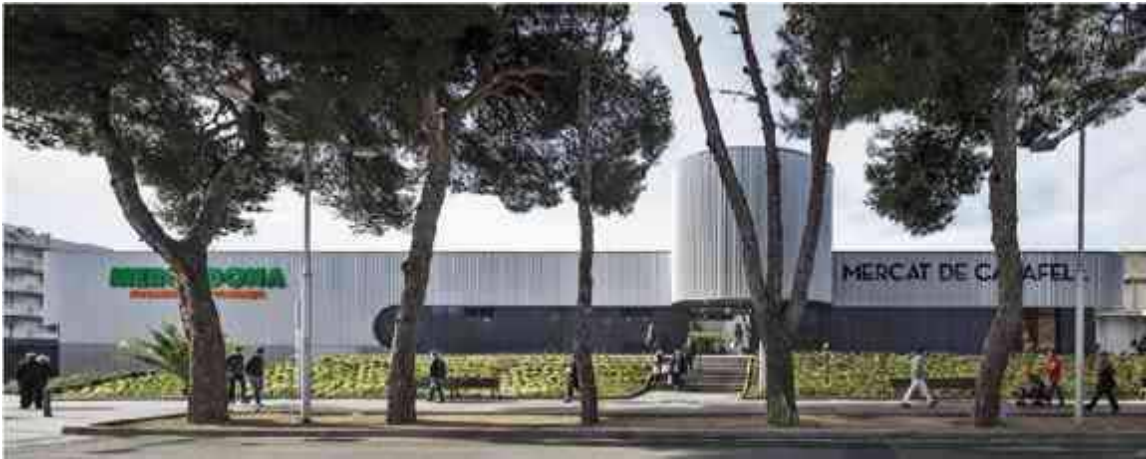
Imagen 30 Fecha 22/11/2014 Fachada principal.
