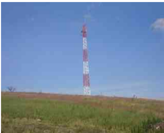
Imagen 47. Antena de Comunicaciones. Foto: Jonnathan M. Morales Camacho. [17/10/2014)
