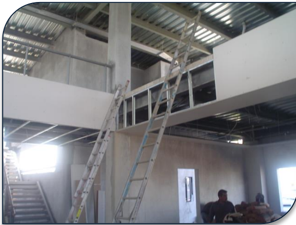
Imagen 60. Instalación de los paneles de durock. Fuente electrónica: https://www.google.com.mx/search?q=tablacemento&sa fe=active&biw=1600&bih=755&source=lnms&tbn=isch&sa (Fecha de consulta: Mayo 2015)
