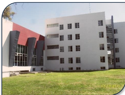
Imagen 11. Vista lateral de la residencia estudiantil. Tecnológico de Monterrey, campus Querétaro. Qro. Fuente: fotografía capturada por el autor
