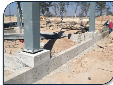
Imagen 55. Conjunto de imágenes que muestran el detalle de cómo se enlaza la estructura de acero a una cimentación de concreto. Fuente electrónica: https://www.google.com.mx/search?q=zapata+aisladas+en+obra%253A%2
