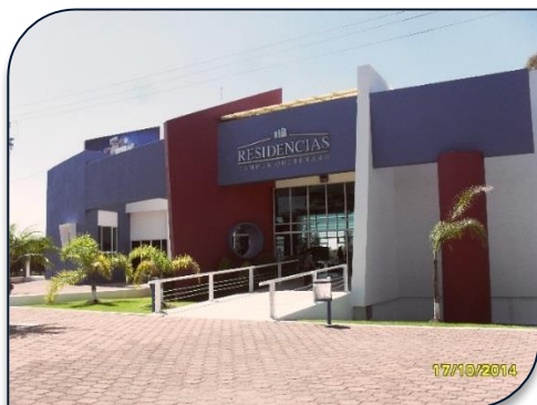
Imagen 10. Fachada de la entrada a la residencia estudiantil. Tecnológico de Monterrey, campus Querétaro. Qro. Fuente: fotografía capturada por el autor
