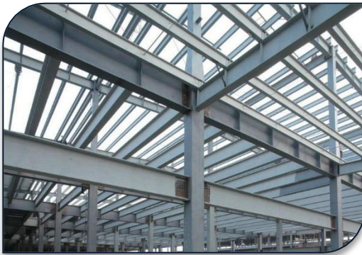
Imagen 56. Estructura de acero. Fuente electrónica : http://www.google.com (Fecha de consulta: Mayo 2015)
