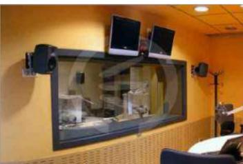
VISOR VR de 2.60 x 1.20, doble cerco metálico, con espesor de 40 mm. doble acristalamiento con vidrios pulidos y montados en perfil de goma en v
