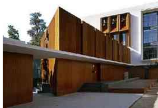
Ilustración 33. Fachada principal Residencia.
