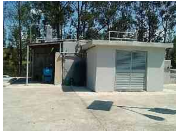
Imagen 78: Cuarto de tratamiento de agua pluvial cuarto de máquinas implementada por el CICEM Fotografía tomada por Ricardo Cruz Porras
