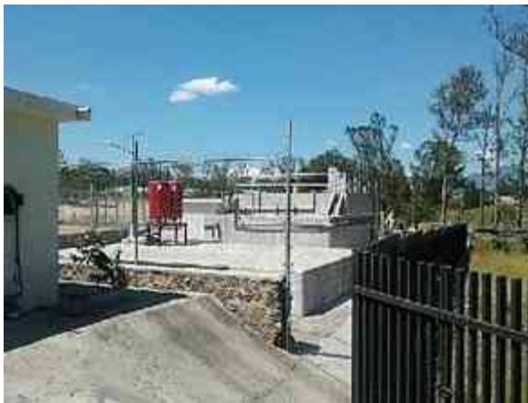
Imagen 79: Cuarto de tratamiento de agua pluvial cuarto de máquinas implementada por el CICEM Fotografía tomada por Ricardo Cruz Porras
