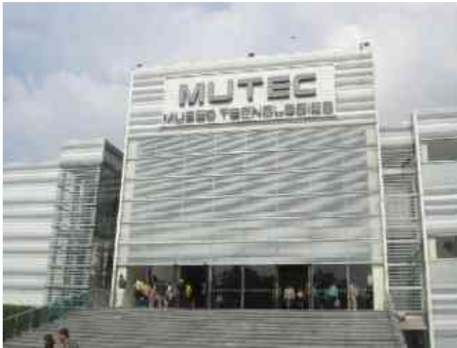
Imagen 23: Fachada principal del MUTECH Fotografía tomada por Ricardo Cruz Porras
