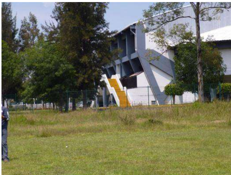
Imagen 21: Vista norte, auditorio de usos múltiples.
