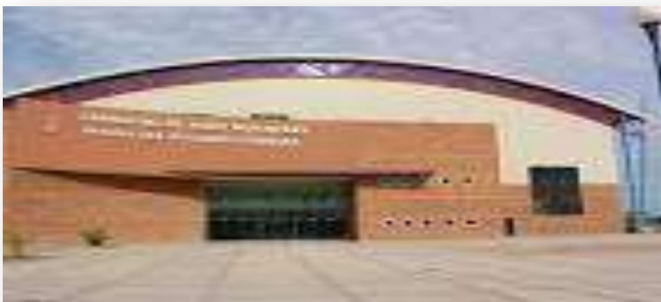
Imagen 13: Vista exterior del gimnasio
