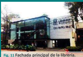
Fig. 11 Fachada principal de la librería.
