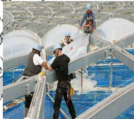
Imagen 28. Instalación de ETFE
