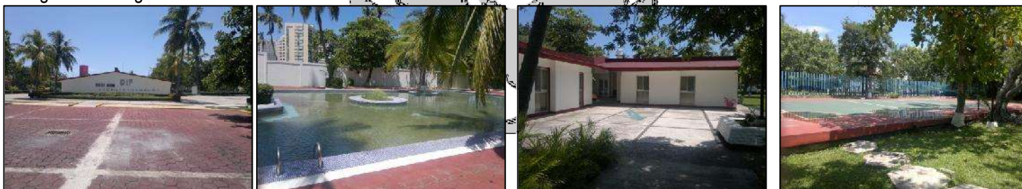
Imagen 14. Fotografías actuales del Centro Recreativo
