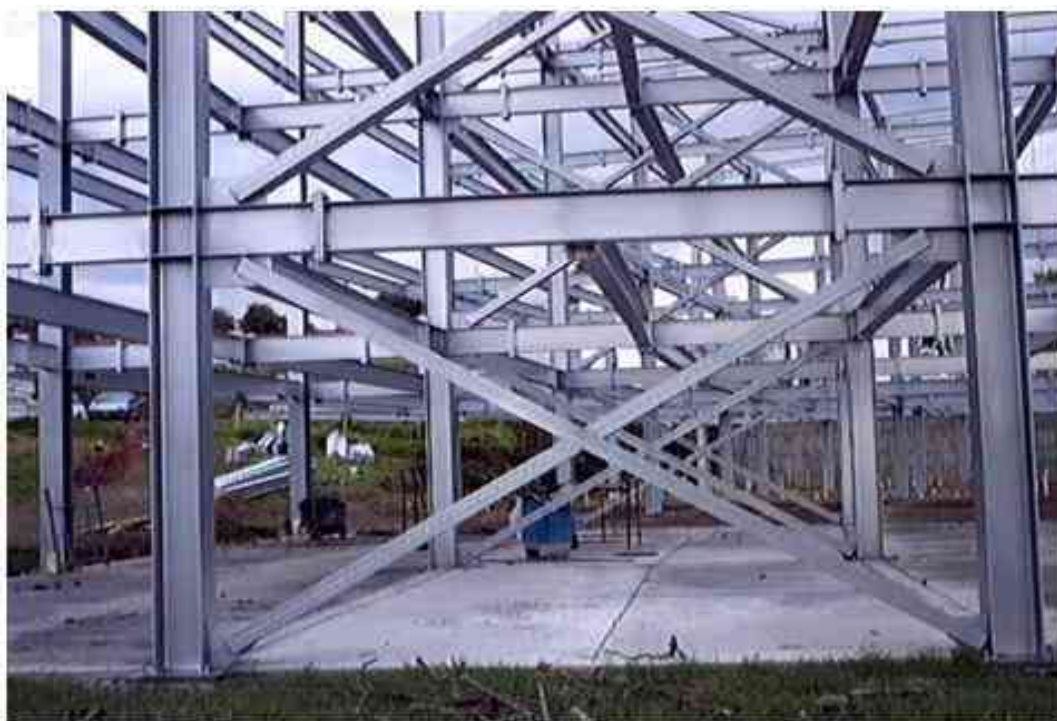
Imagen 41: Estructura a base de marcos
