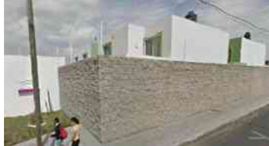
Imagen. 3- Fachada sur de Estancia Infantil La Consolación. Fuente WEB
