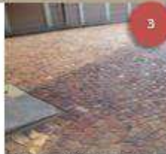
Piso de pórfido para la plazuela del lado norte del edificio.
