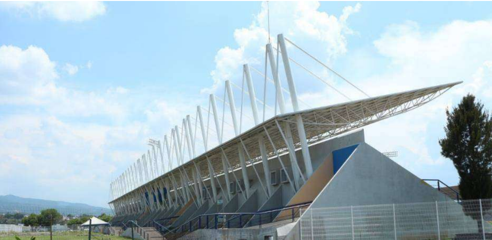
Imagen 54, 55 y 56. Edificaciones en Ciudad Universitaria
