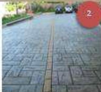
Piso de concreto estampado para los pasillos, la plazuela de acceso al edificio.
