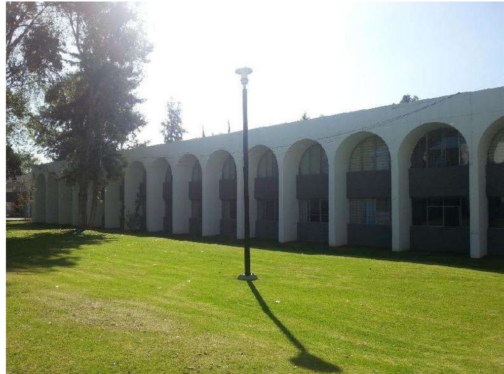
Imagen 2. Edificio W, Ing. Mecánica
