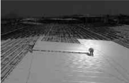
Imagen 100. Cubierta para nave industrial hecha con multipanel
