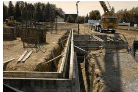
Imagen 99. Concreto armado en cimentaciones.
