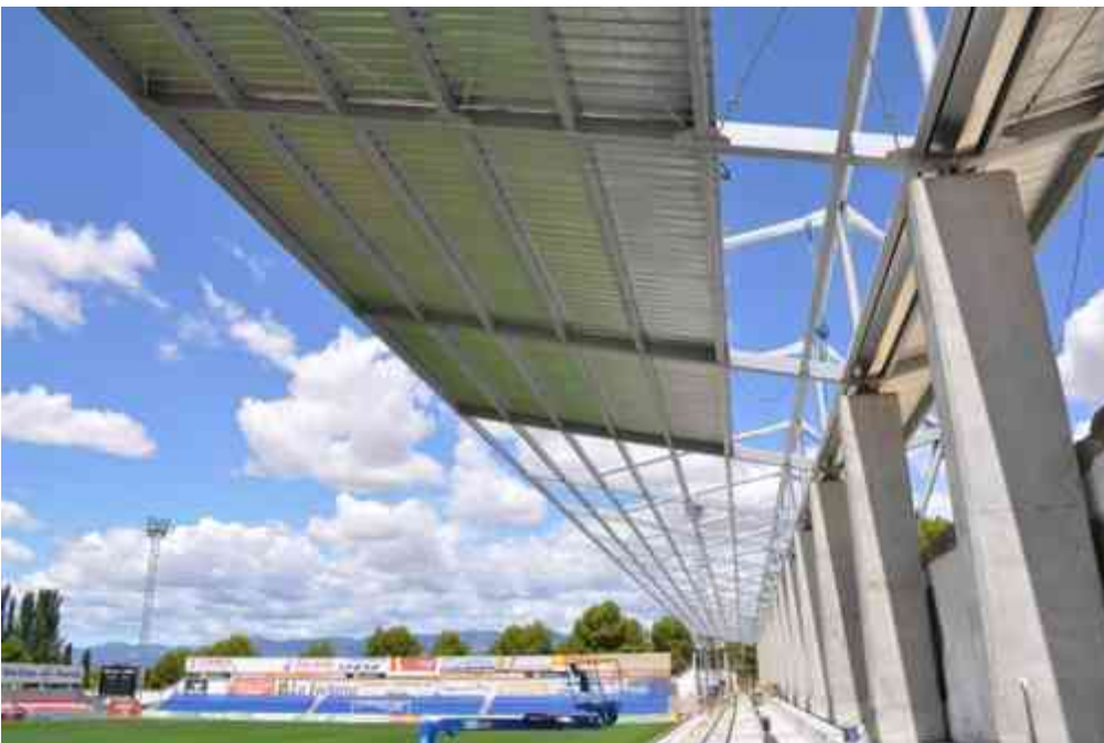
Foto 5 cubierta metálica, se puede apreciar la cubierta metálica apoyada sobre columnas de concreto foto: http://tallereslupi.com/upload/max/20130130184155.jpg
