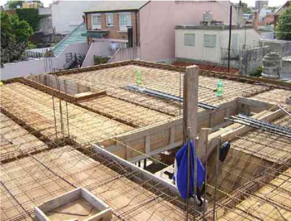
Foto 4 losa maciza, en esta foto se puede apreciar el armado y el cimbrado de una losa maciza foto: http://notas.arquitectosve.com.ar/wp-content/uploads/2009/10/BA-Losa-s-1%C2%B0-2.JPG
