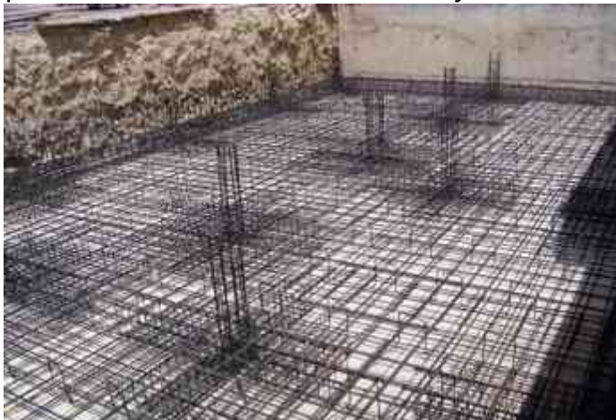
Foto 2 losa de cimentación, en esta foto se pueden apreciar el armado en una losa aligerada, de la cual se desplantan los castillos foto: http://www.arxhitec.com/wp-content/uploads/2014/03/obra-017.jpg
