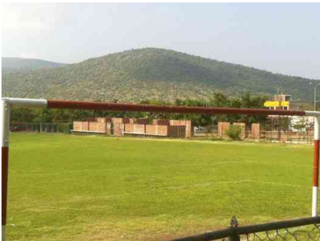
Imagen 2 cancha de futbol de la unidad deportiva municipal, al fondo la construcción de las gradas. 15-oct-2014 fotos: Leonel Núñez Arzate
