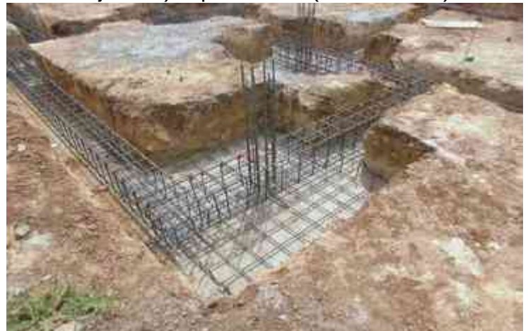
Foto 1 zapata corrida, en esta foto se aprecia el armado de la trabe que va corrida a los castillos foto: https://konstruir.files.wordpress.com/2013/09/dsc09524redim.jpg
