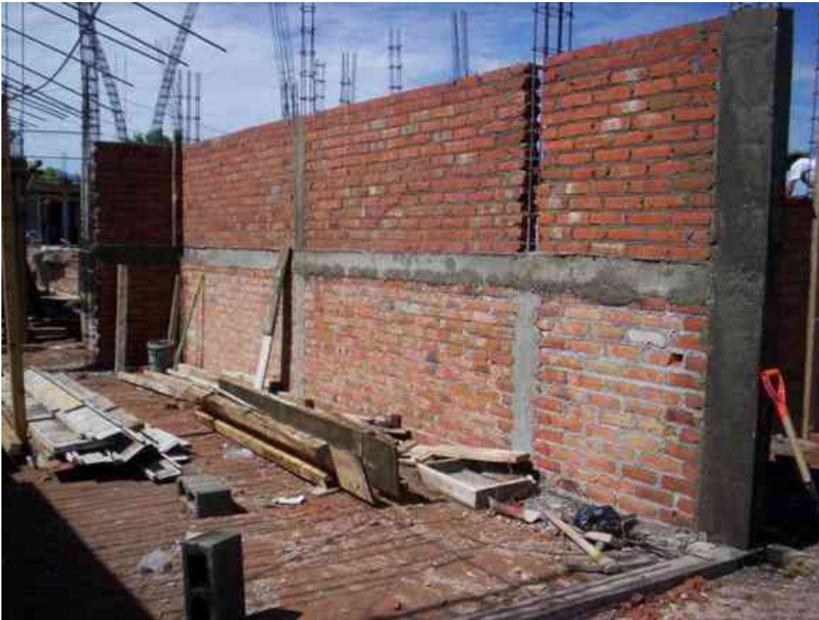
foto 8 muro estructural de tabique rojo de la región foto: http://www.aguascalientes.gob.mx/transparencia/calidad/sop/Obras/ReportesVarios/imagen.asp?id=14788
