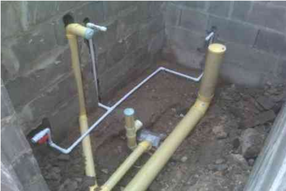
foto 6 instalación de tuberías hidráulica y sanitarias foto: http://img.webme.com/pic/c/construccionespompilio/8.jpg
