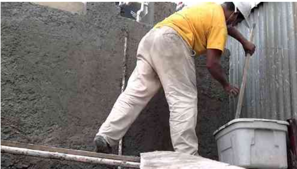
foto 9 apalanado a base de mortero-arena foto: https://i.ytimg.com/vi/umHwIRHgHt4/maxresdefault.jpg
