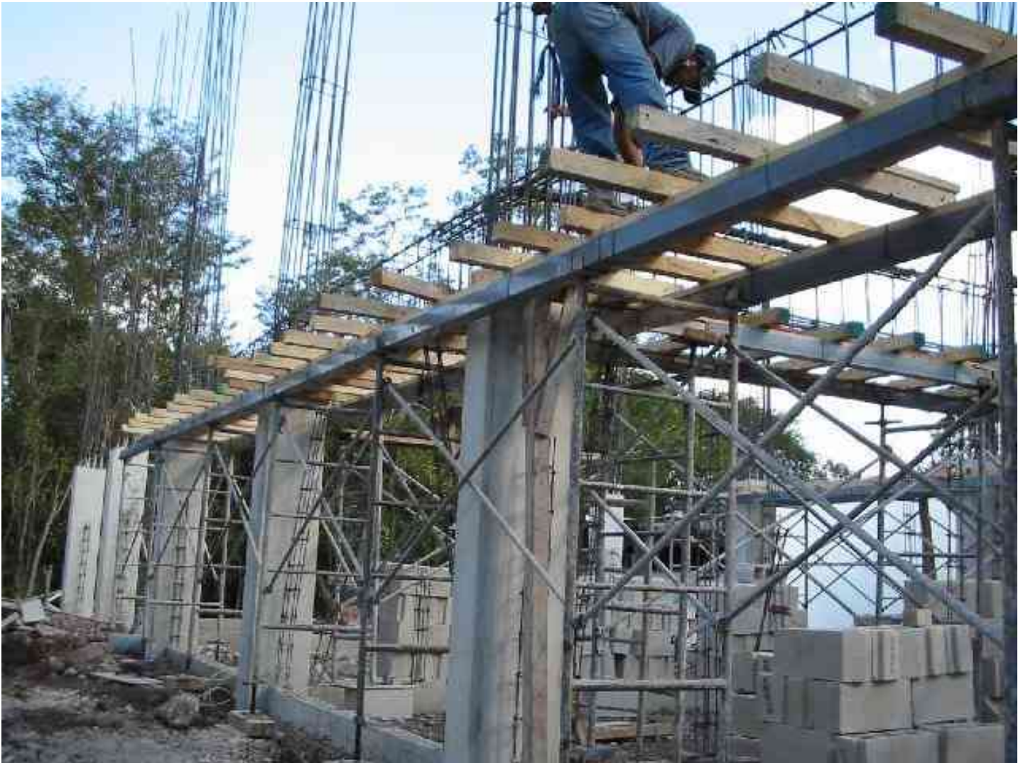
Foto 3 estructura de concreto, en esta foto se puede apreciar las columnas de concreto así como el armado de las trabes foto: http://i.anunciosya.com.mx/i-a/vVEf-7.jpg
