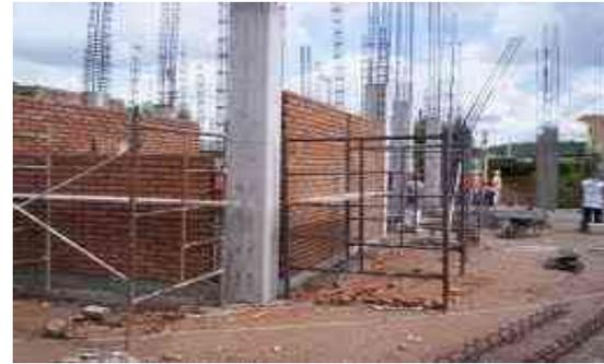
Ilustración 61: Muros de Tabique
