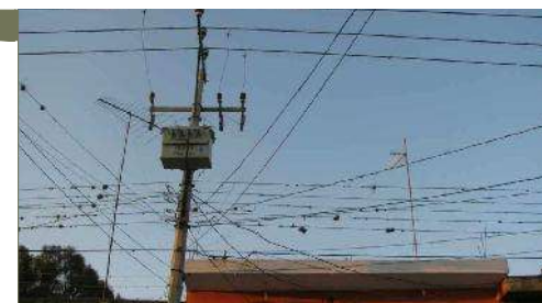
IMAGEN: POSTE DE CONCRETO
