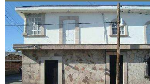
IMAGEN: POSTE DE MADERA
