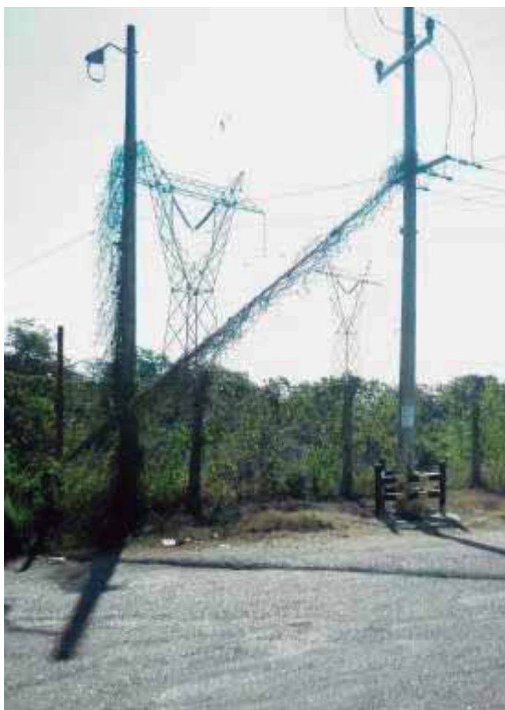
IMAGEN 55. Líneas telefónicas [Foto: EPGM]
