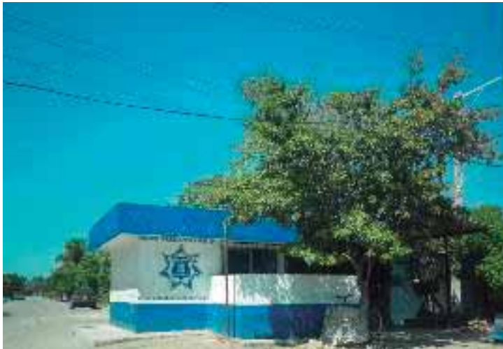
IMAGEN 47. Modulo de seguridad pública [Foto: EPGM]
