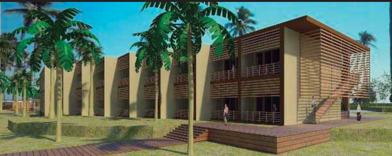
VISTA 3. Fachada Sureste Hotel - Hora: 11:00
