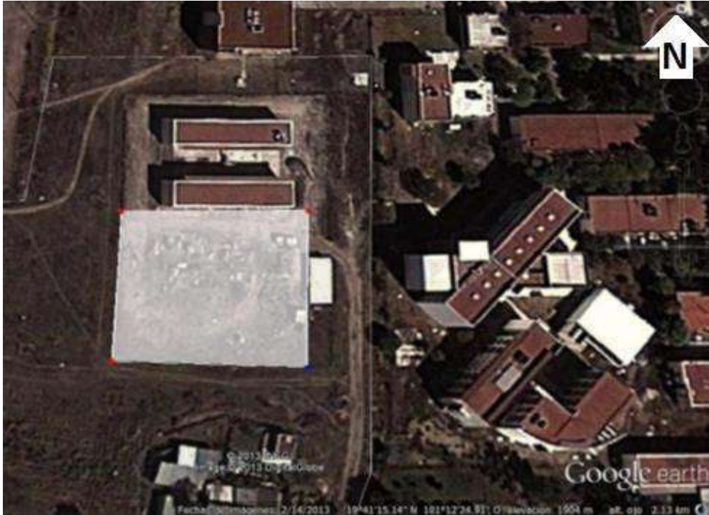
Imagen 2. Localización del predio. Fuente: Google Earth 2013. (10/12/2014)
