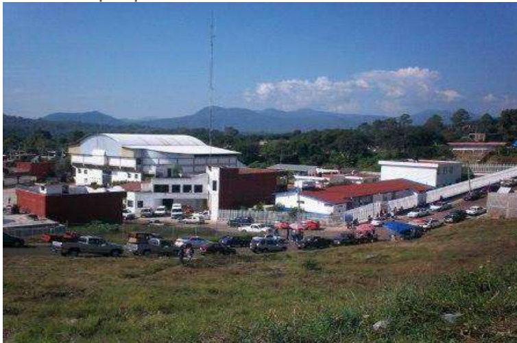
Imagen 36. Se muestra la unidad de protección civil (derecha) y el auditorio municipal (izquierda). Fuente. elas.com.mx
