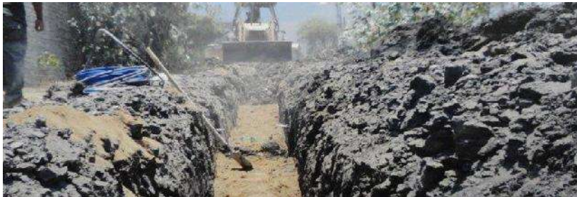
Imagen 37. Reparaciones de infraestructura en Tacámbaro. Fuente. Quadratin.com.mx
