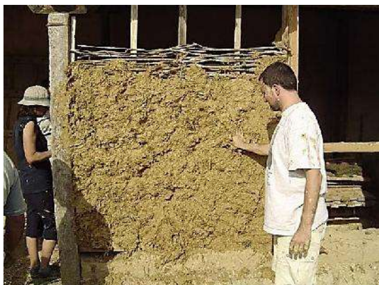
Imagen 68.— Muro bajareque Fuente: https://riunet.upv.es/handle/10251/1422
