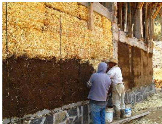
Imagen 72.- Construcción de muros de paja Fuente: http://bioconstruyendomurcia.blogspot.mx/2011/11/etapa-5-levantamiento-del-muro-de-paja.html
