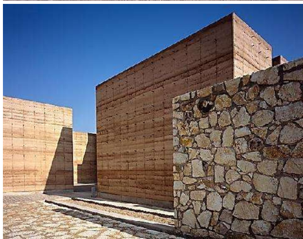
Imagen 38, 39.— Exterior de la escuela de Artes Plásticas Fuente: http://revistaaxis.com.co/noticia/584_color-tierra
