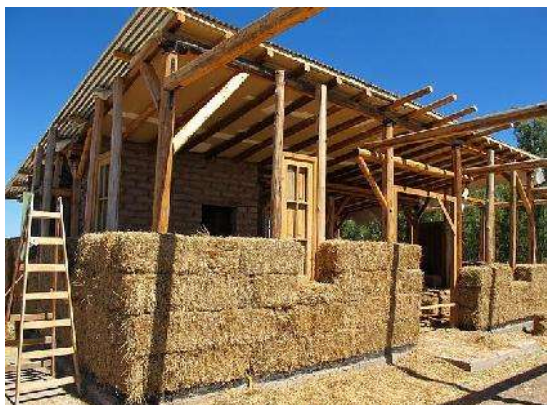
Imagen 70.— Construcción de muros de paja Fuente: http://www.movingforwardblog.org/2012/06/materiales-ecologicos-para
