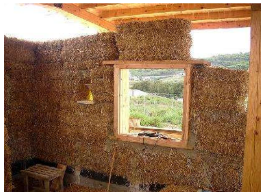
Imagen 71.— Construcción de muros de paja Fuente: http://www.movingforwardblog.org/2012/06/materiales-ecologicos-para
