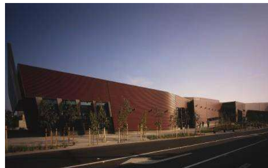
Imagen 12.— Fachada de centro comunitario Fuente: http://www.landaarquitectos.mx/
