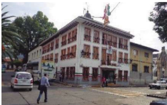
Figura 15 Chávez, A. Oct. 2015. Edificio de SHCP administración pública federal en Uruapan, realiza actividades de atención de usuarios y contribuyentes.
