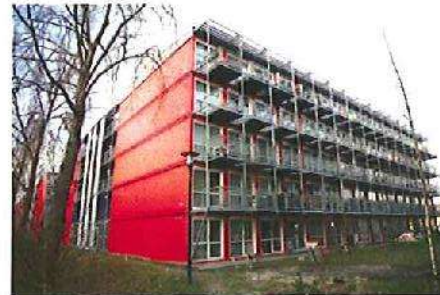
Imagen No.93.- Este edificio de habitaciones, nos muestra cómo se pueden apilar verticalmente los contenedores.
