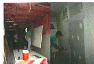
Imagen No. 67.- Colocación y acabado de la tabla de yeso.
