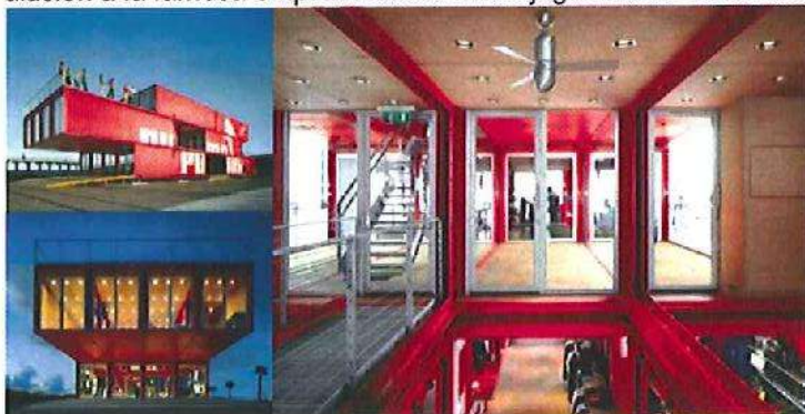
Imagen No. 18.- Ejemplo de reutilización de contenedores marítimos para la realización de la obra denominada "Ciudad PUMA", estructura que es montada y desmontada temporalmente en diversos lugares, con el fin de dar a conocer los productos de la marca ya mencionada.
