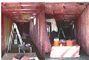
Imagen No. 66.- Fibra de vidrio colocada, lista para recibir tabla de yeso.
