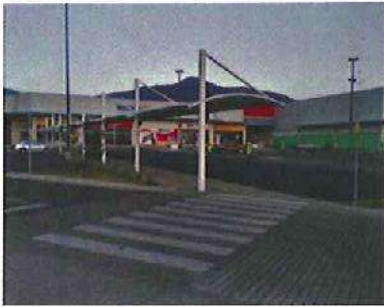
Imagen No. 86.- Macroplaza Estadio, construida con materiales innovadores, tanto tradicionales, como prefabricados.
