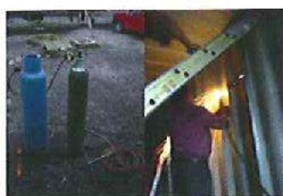
Imagen No. 64.- Trabajo de oxicorte en la habilitación de un contenedor
