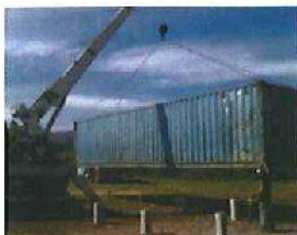
Imagen No. 22 Instalación del contenedor.
