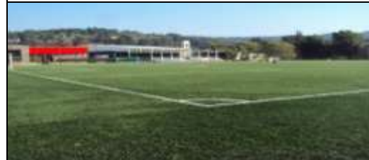
Foto 30.-Interior de la Unidad Deportiva
