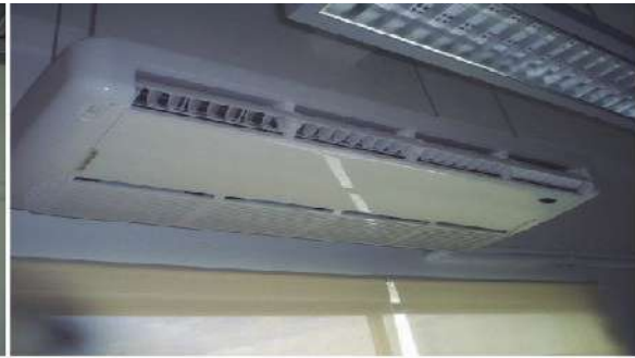
Figura 12 Unidad Evaporadora tipo Piso Techo de aire acondicionado tipo Mini Split. Tomada en Coca Cola Mega Morelia. 10/Sep/2015 (AEAF).
