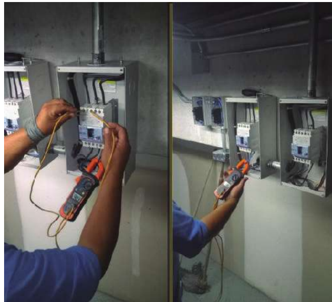
Figura 57 Toma de lectura con el amperímetro. Tomada en Tienda Zara área Trafa en Centro Comercial Las Américas en Morelia, Mich. 28/Mar/2016
