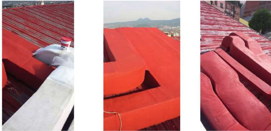
Figuras 75 Ductos de lamina galvanizada cal. 24, aislamiento térmico para ductos exteriores a base de colchoneta de fibra de vidrio tipo RF 3075 de 1" de espesor con barrera de vapor a base de papel Bond Alum, adherido con pegamento sigma y sellado en traslapes tipo fiber va. Incluye membrana, pegamento y pintura ahulada e impermeabilizante terracota. Tomadas en Cinepolis Morelia Centro. 4/Agos/2015 (AEAF).
