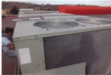
Figura 44 En la foto se puede apreciar al técnico realizando el mantenimiento a una unidad tipo paquete. Tomadas en DeAcero, 12/Ene/2013. (AEAF).
