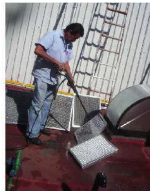
Figura 54 Limpieza de Filtros de unidad Manejadora de agua. Tomada en Plaza Las Américas. 18/Feb/2010 (AEAF)
