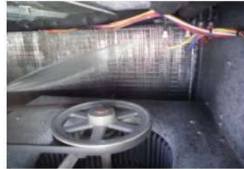
Figura 45 En la foto se puede apreciar como se lava los filtros metálicos con agua a presión durante el mantenimiento a la unidad tipo paquete. Tomadas en DeAcero, 12/Ene/2013. (AEAF).
