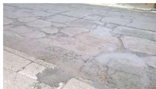
Ilustración 54. Pavimentación en deterioro. Autor: EJR
