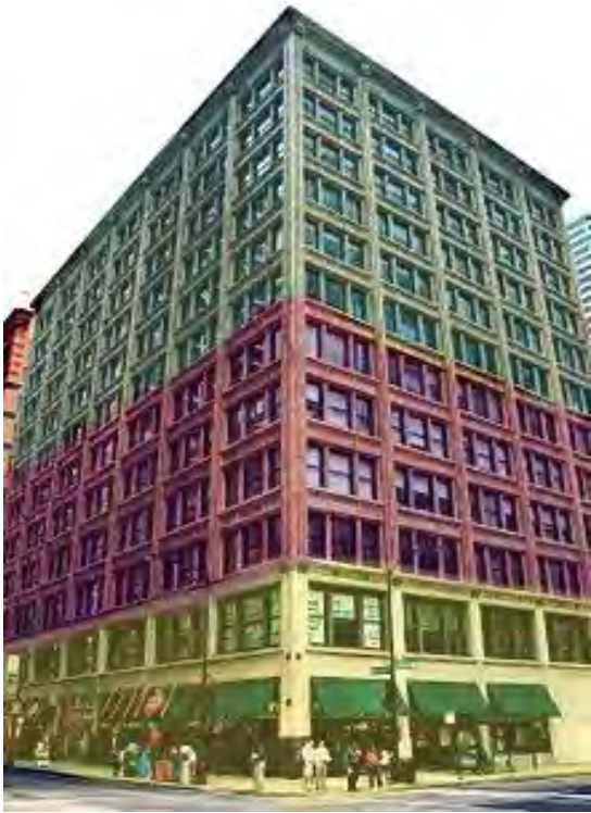
Fig. 6.- Esquema de la zonificación de los edificios de la escuela de Chicago.
