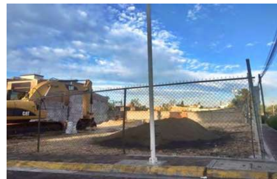
Figura 17. Fachada oeste del terreno, SRG.
