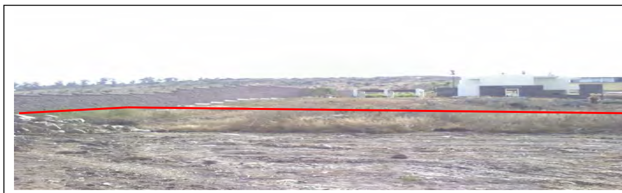
FOTOGRAFÍA FOT/013: EN LA FOTOGRAFÍA SE MUESTRA EL LATERAL DEL TERRENO CON VISTA HACIA EL PONIENTE, MOSTRANDO LA EXCAVACIÓN REALIZADA PARA EL TRAZO Y NIVELACIÓN. (2009) ARCHIVO PERSONAL
