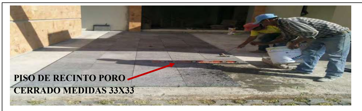
IMAGEN 042: COLOCACION DE PISO RECINTO PORO CERRADO FORMATO 33X33 A HUESO SIN JUNTA ESTIPULADO POR EL INCISO R4.2.6 REGLAMENTO DE DISEÑO DE TRES MARIAS (2015) ARCHIVO PERSONAL.
