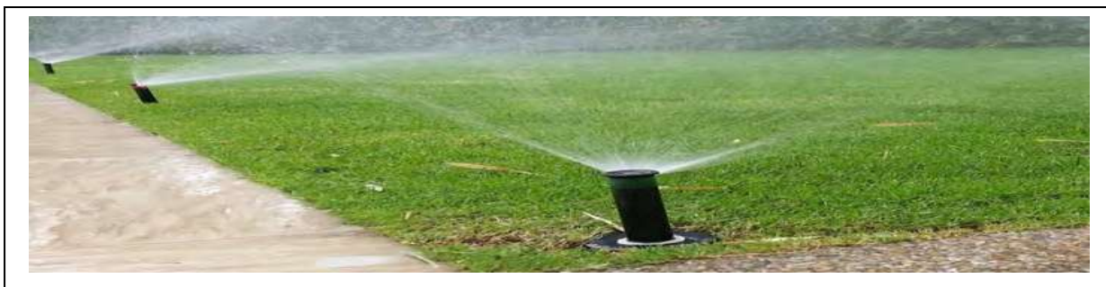
IMAGEN 052: COLOCACION DE SISTEMA DE RIEGO DE ACUERDO CON EL INCISO R4.3.2 REGLAMENTO DE DISEÑO DE TRES MARIAS (2015) ARCHIVO PERSONAL.
