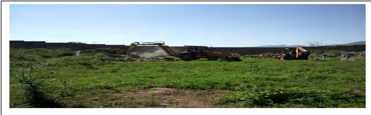
FOTOGRAFÍA FOT/011: VISTA FRONTAL DEL TERRENO CON DIRECCIÓN HACIA MURO PERIMETRAL DEL FRACCIONAMIENTO, SENTIDO DE CÁMARA NORTE-SUR. EN EL TERRENO TRABAJANDO DOS RETROEXCAVADORAS PARA LIMPIAR EL TERRENO.(2009) ARCHIVO PERSONAL
