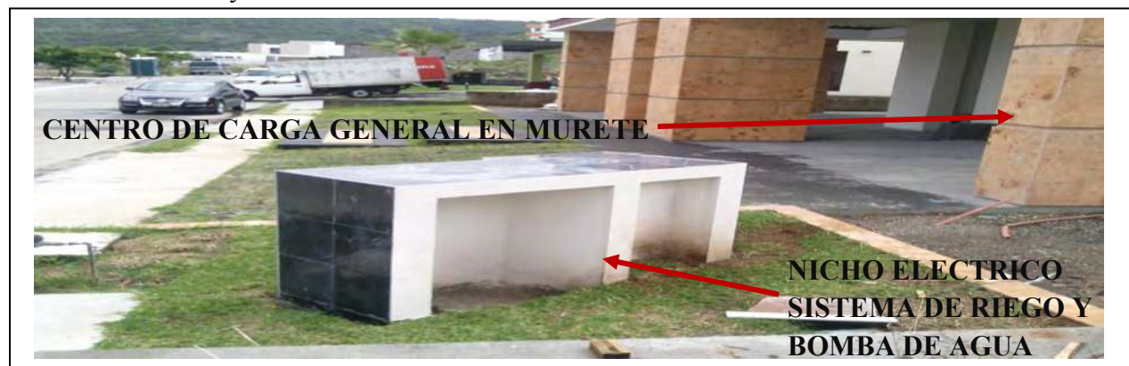
IMAGEN 043: ELABORACION DE NICHO ELECTRICO PARA SISTEMA DE RIEGO Y TOMA DOMICILIARIA DE AGUA ESTIPULADO POR EL INCISO R4.2.8 REGLAMENTO DE DISEÑO DE TRES MARIAS (2015) ARCHIVO PERSONAL.
