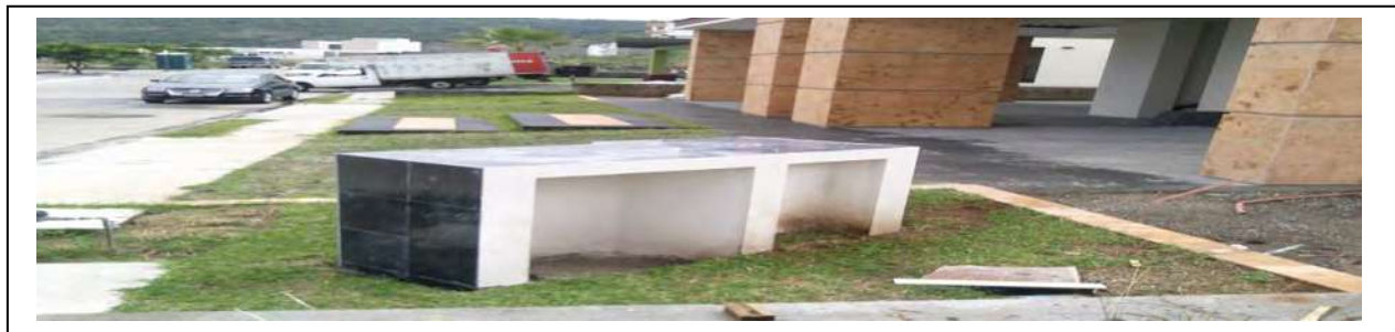
IMAGEN 047: SE REALIZARON NICHOS PARA ALOJAR LOS SERVICIOS HACIA LA PROPIEDAD, ESTIPULADO POR EL INCISO R4.2.16 REGLAMENTO DE DISEÑO DE TRES MARIAS (2015) ARCHIVO PERSONAL.
