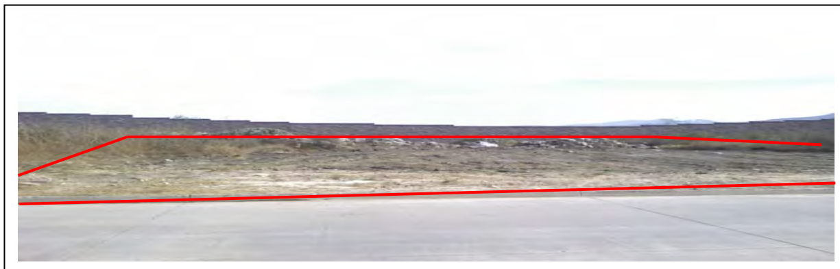
FOTOGRAFÍA 012: EN LA FOTOGRAFÍA SE MUESTRA EL TERRENO EL CUAL SE VACIÓ HASTA UNA PROFUNDIDAD DE 1.50M EN PROMEDIO, PARA HACER EL MEJORAMIENTO DEL TERRENO Y PODER RECIBIR LA PLATAFORMA DE CIMENTACIÓN. DELIMITÁNDOLO EL TERRENO CON UNA LÍNEA ROJA EL PERÍMETRO. (2009) ARCHIVO PERSONAL
