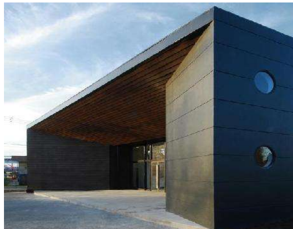
Fig.23 Imagen 19 terminal de buses los lagos, perspectiva 2, http://www.archdaily.mx/[12/09/14]
