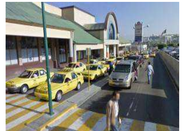
Fig.12 Imagen 8 central de autobuses Querétaro, fachada principal, Http//www.skyscraperlife.com , [12/09/14]
