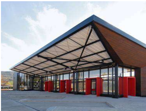
Fig. 22 Imagen 18 terminal de buses los lagos, perspectiva 1, http://www.archdaily.mx/[12/09/14]
