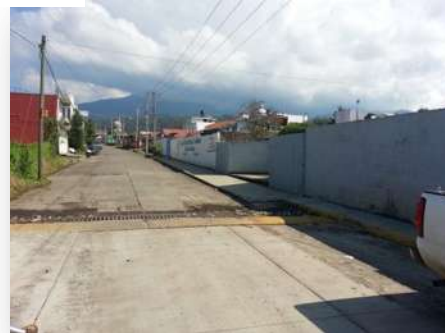
Fig.37 Foto.05 Tomada: Eduardo Díaz Viveros, Alcantarillas de drenaje
