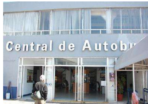
Imagen 13. Fachada Principal Central de Autobuses de Zamora, Michoacán. Fotografía www.lavozdemichoacan.com.mx
