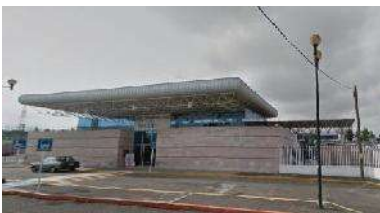
Imagen 21. Fachada – Parada de taxis.
