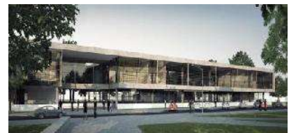
Imagen 42. Acabado cristal como envolvente del edificio. Predominio de vano sobre macizo.
