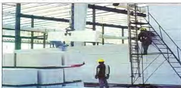
**Fig.62** Desflejado y colocado de tenaza en paneles
