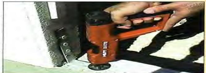
Fig. 15: Fijación del conector inferior (conector tipo "B").
