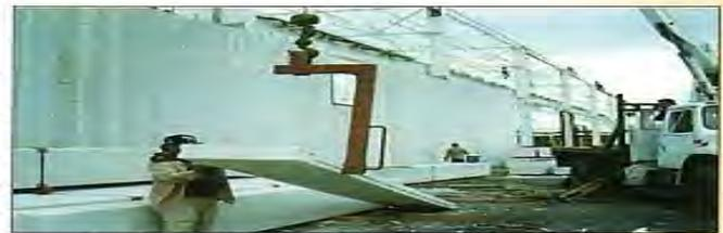
Fig. 14: Colocación del gancho e izaje del panel.
