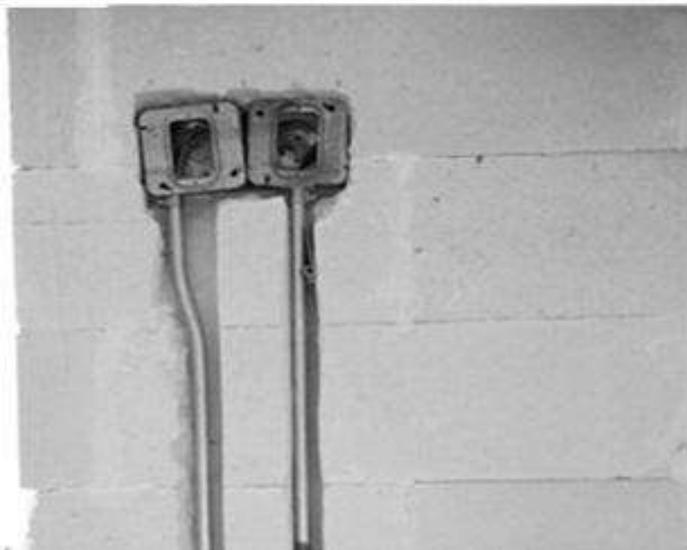
Fig.71 contactos y registros eléctricos
