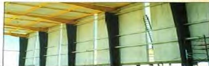
Configuración de paneles para losa y muro en trave industrial.
