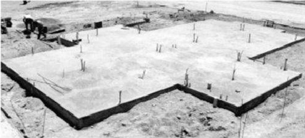
**Fig.80** Firme de concreto.
