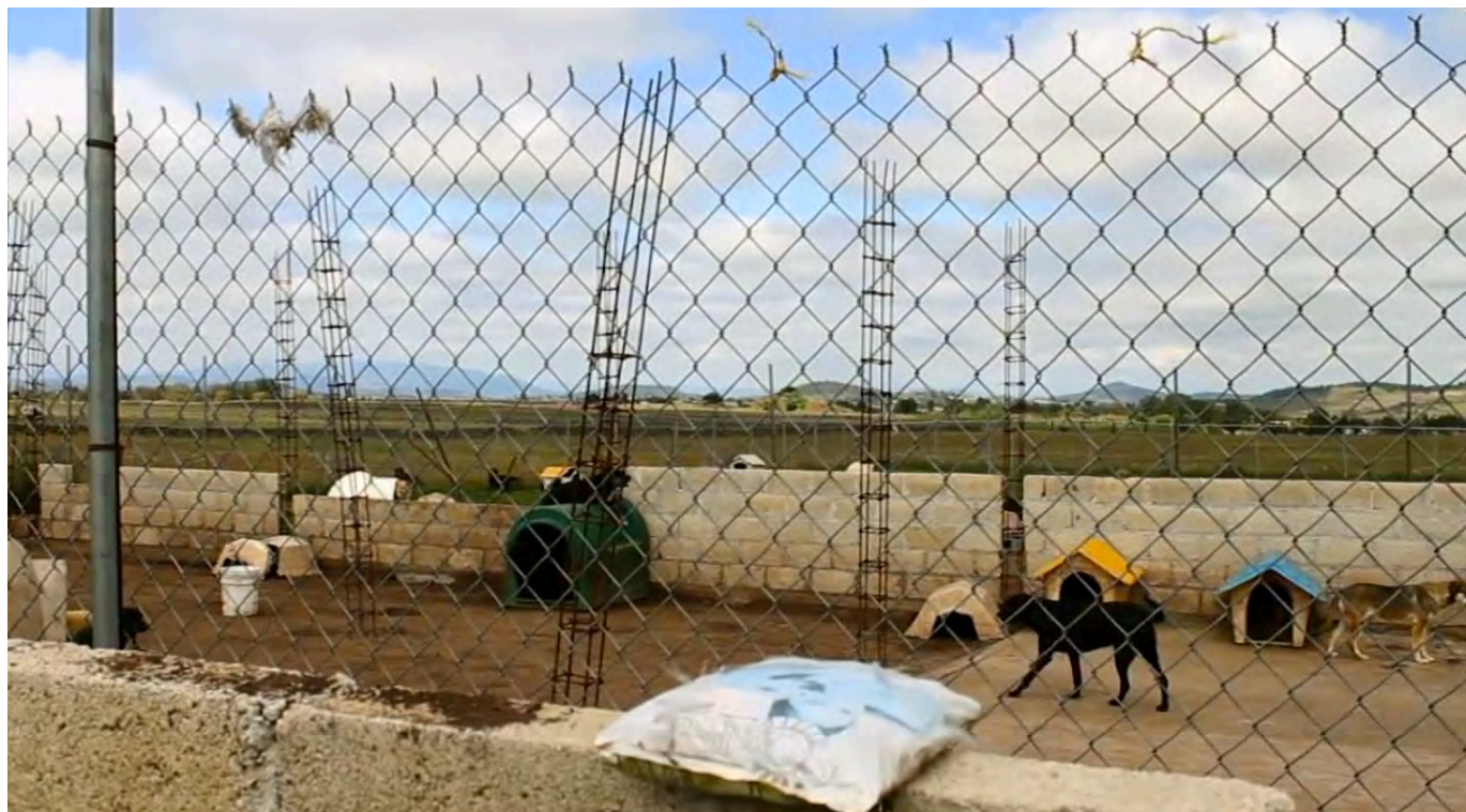
Imagen 32. Área en proceso de construcción Albergue San Cristóbal. Captura de video promocional oficial del refugio. Fuente: http://www.alberguesancristobal.org/
