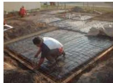
Imagen 83. Losa de cimentación
