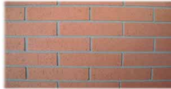
Fig. 68 Muro de tabique aparente
