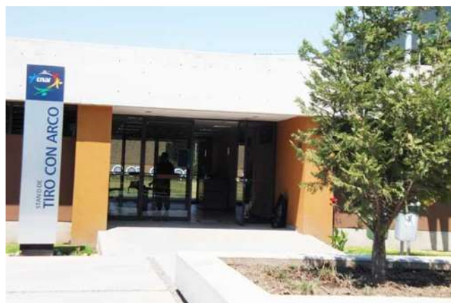
59 Fachada principal pabellón tiro con arco.
