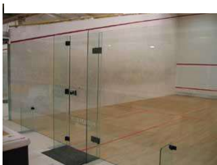
74 Sala con aislante acústico y vidrios resistentes al impacto.
