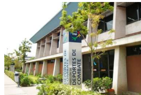
51 Fachado principal Pabellón de combate.
