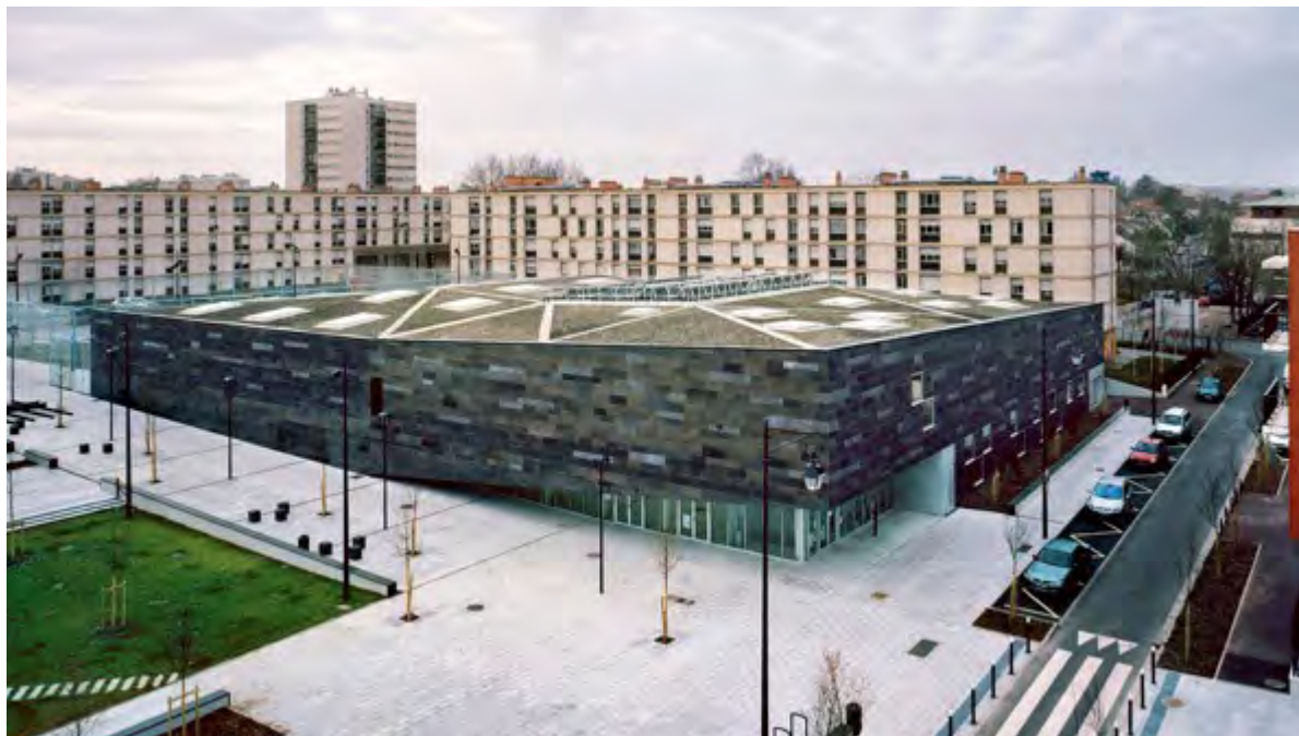
Imagen No. 32. Cubierta vegetal (ArchDaily México, 2014).
