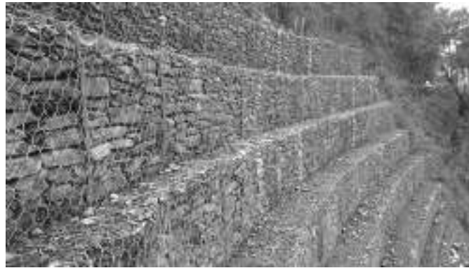
Imagen 39: Muro de contención de gaviones.
