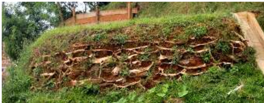
Imagen 38: Muro de contención de sacos de tierra
