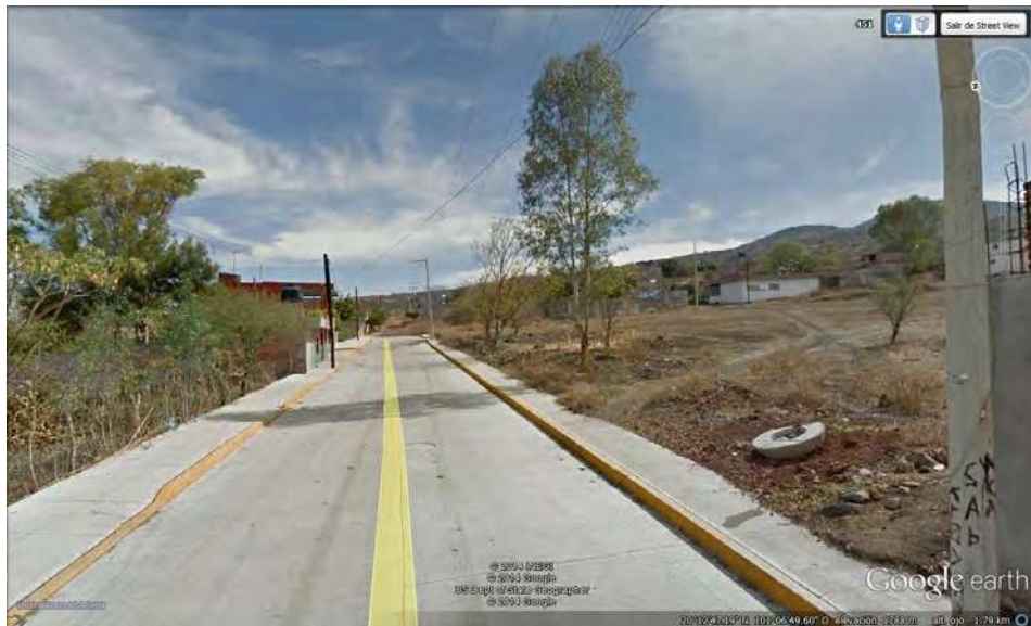
IMAGEN 41.- Frente del Terreno (oriente-poniente) por la calle Narciso Mendoza 59
