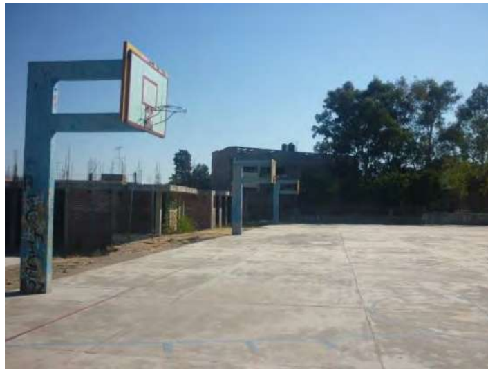
IMAGEN 19.- Unidad Deportiva (posición de los tableros lado norte)
