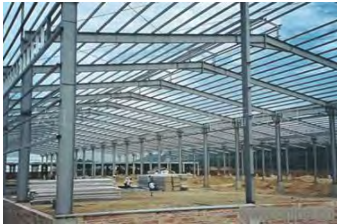
IMAGEN 68.- Armadura estructural de Acero.
