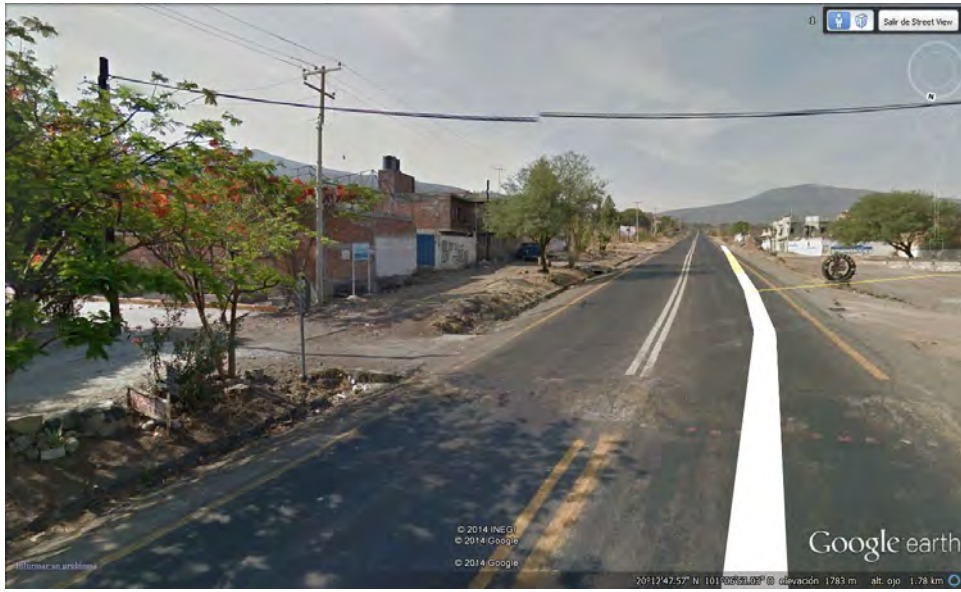
IMAGEN 40.- Acceso al terreno por calle Narciso Mendoza (norte-sur) 58
