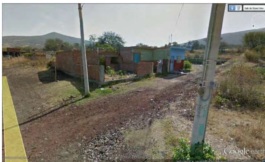
IMAGEN 49.- acceso al Terreno por la calle sin nombre
