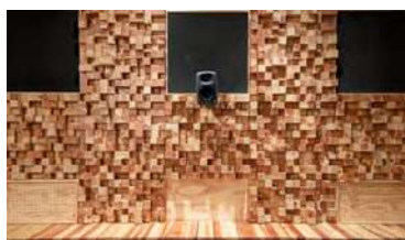
Paneles móviles absorbentes y difusores
