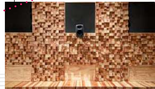
Paneles móviles absorbentes y difusores
