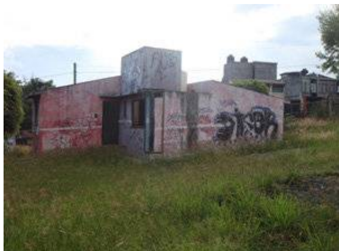
Vista 4 de inmueble en desuso en el terreno al oeste.
