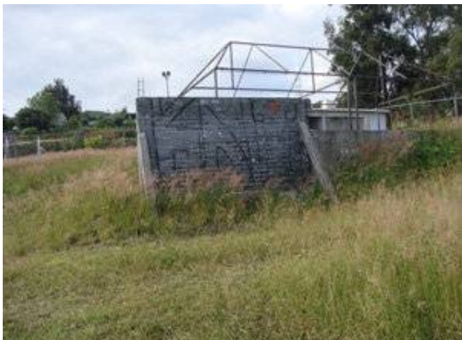
Vista 3 de estructuras de concreto en el terreno al noroeste.
