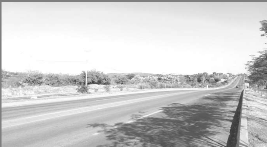
Pavimento de la AV 22 de Octubre, acceso principal al predio.
