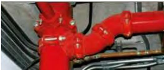
Imagen 3.1.11 de tubería de red contra incendio de acero de alta resistencia negro recubierto con barniz protector
