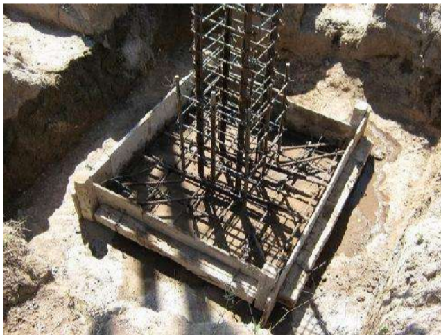
Imagen 46. Armado de zapata aislada. Fuente: https://www.google.com.mx/search?q=imagen+de+zapata+aislada&biw=1366&bih=643&tbn=isch&imgil=q3o6d39vSVqmOM%253A%253BsYEfwQ0Sx05IHM%253Bhttp%25253A
