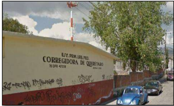
Imagen 29, Escuela Primaria Urb. Fed. Corregidora de Querétaro. Fuente: Propia.
