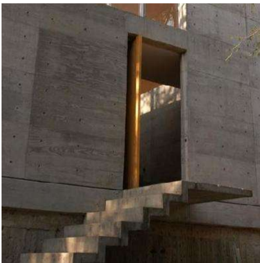
Imagen 49 , Ejemplo de concreto aparente aplicado en fachada Fuente: http://enlacearquitectura.com/14296-2/
