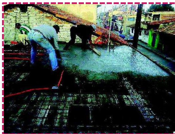
Ilustración 32 Colado en losa (Foto tomada por autora)
