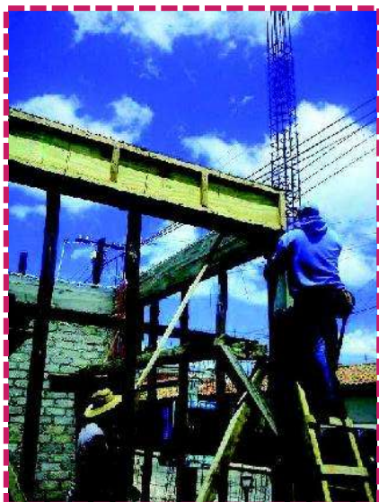
Ilustración 33 Colado en trabe (Foto tomada por autora)
