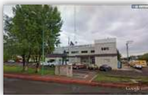
Imagen 4: cuerpo de bomberos protección civil Morelia. Tomada de: google earth (septiembre 2015)
