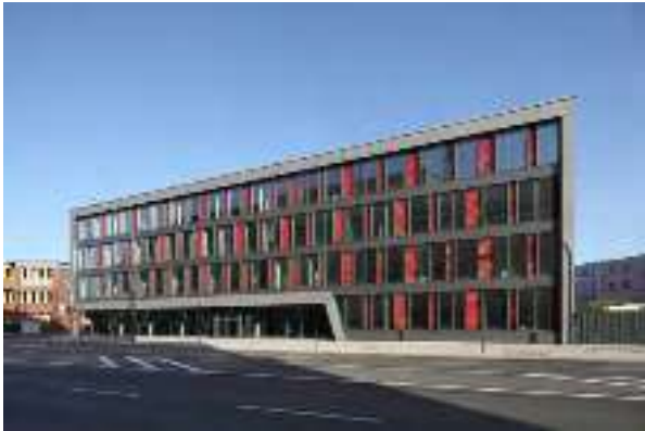
Imagen 38: caso internacional tomada de: Estación de Bomberos 1 / agn Niederberghaus & Partner GmbH http://www.archdaily.mx/ [fecha de consulta: Octubre de 2015].
