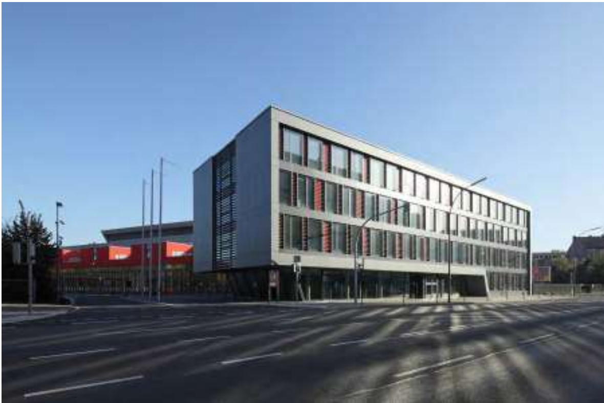
Imagen 42: fachada principal de estación de bomberos ubicada en Alemania, Steinstraße 25, 44147 Dortmund. Tomada de: http://www.archdaily.mx/ [fecha de consulta: octubre de 2015].
