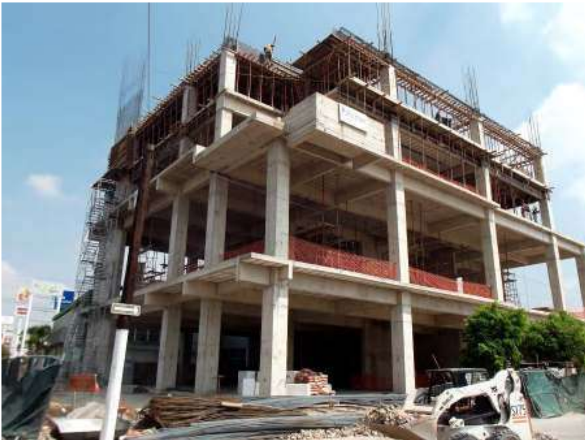
Imagen 109: edificio con estructura de concreto. Tomada de: http://palomarestructuras.com/construccion-en-avila-camacho/ [octubre 2015]
