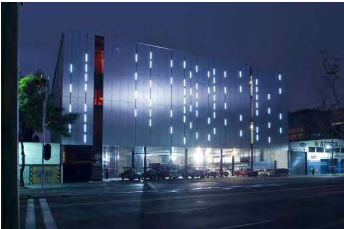
Imagen 47: Estación de bomberos Ave Fénix. Tomada de: http://www.archdaily.mx [fecha de consulta: octubre de 2015].
