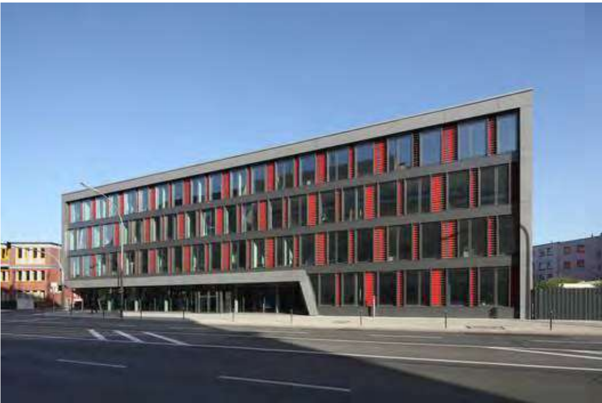
Imagen 41: fachada principal de estación de bomberos ubicada en Alemania, Steinstraße 25, 44147 Dortmund. Tomada de: http://www.archdaily.mx/ [fecha de consulta: octubre de 2015].
