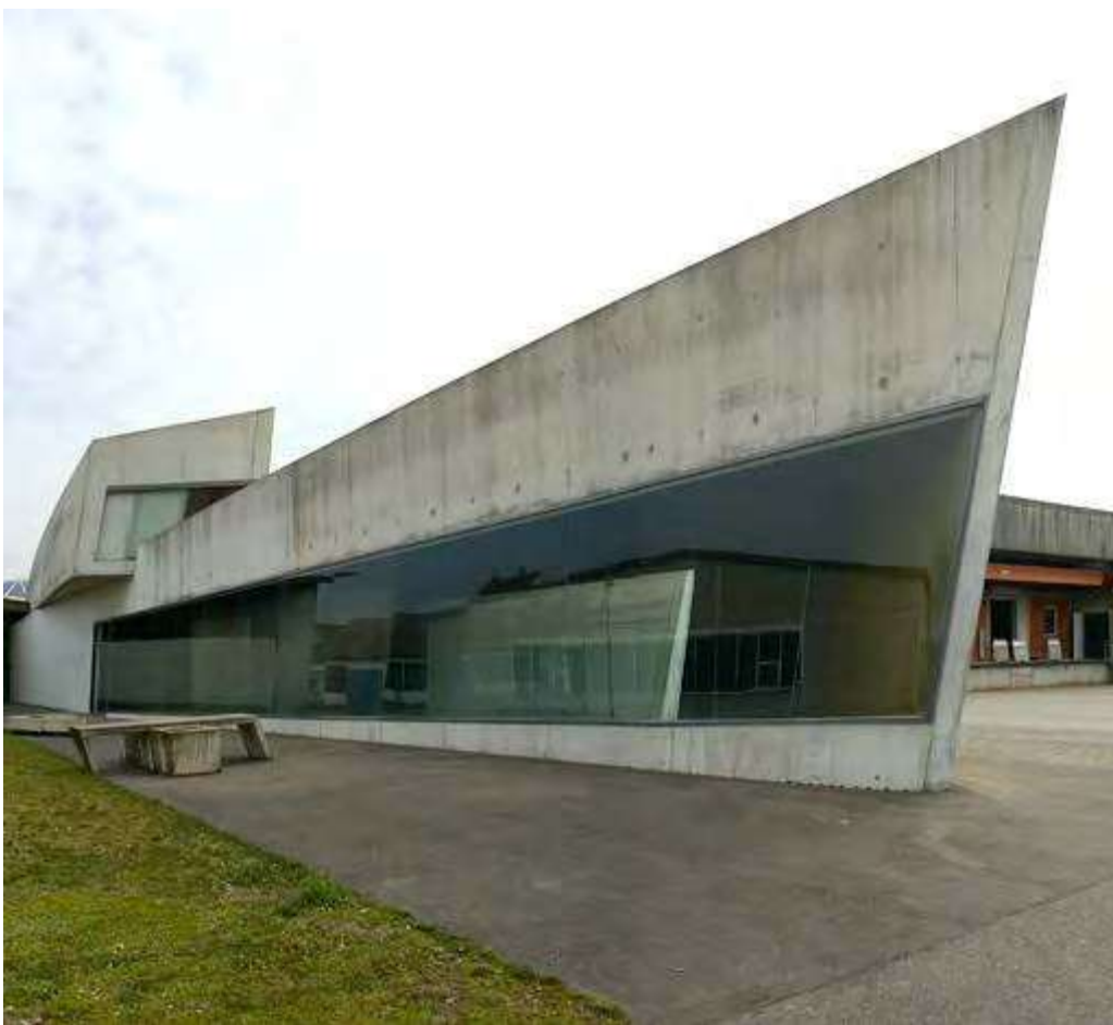
Imagen 44: estación de bomberos vitra. Tomada de: http://es.wikiarquitectura.com/ [fecha de consulta: octubre de 2015].
