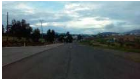
Imagen 103: Angulo B, vialidad primaria en el predio. Foto tomada por: Israel Benítez Reynoso.
