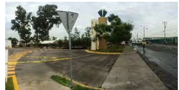
Fotografía 19. Pavimento de las calles de acceso al predio. Tomada por Ilse Cahue.
