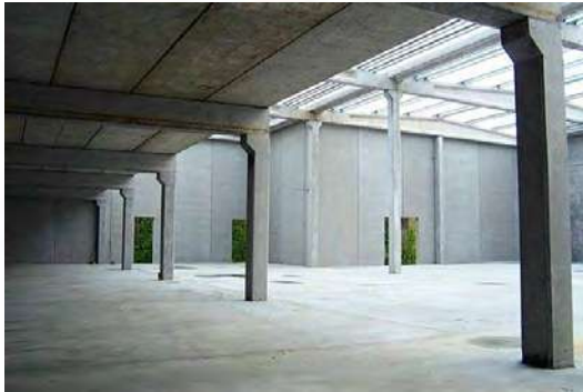
Fotografía 27. Estructura a base de vigas y columnas prefabricadas. Recuperada de: Sistemas constructivos prefabricados aplicables a la construcción de edificaciones en países en desarrollo. Fecha de consulta: 22/O9/15.
