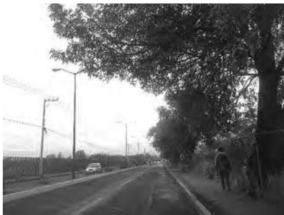
Fotografía 16. Pavimento de la calle principal de acceso al predio Tomada por Ilse Cahue.
