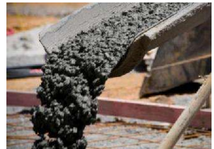
Ilustración 130. Concreto como parte de la estructura de soporte. Fuente: google imágenes.
