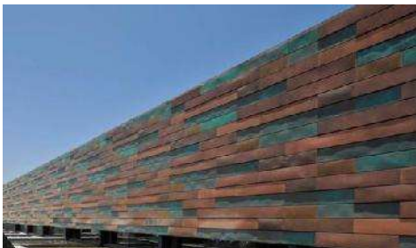
Ilustración 131. Revestimiento acústico exterior del edificio con paneles de aluzinc. Fuente: google imágenes.
