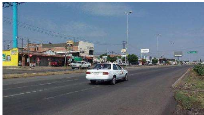
Ilustración 25. Vista de la carretera Federal N°90 desde el terreno propuesto. Fecha: (20/Mayo/2016). Tomada por el autor.
