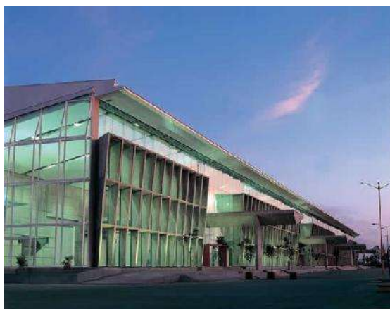
Ilustración 61. Fachada del Centro de Congresos y Convenciones de León. Fuente: Google imágenes. Fecha de consulta: (28/Nov/15).
