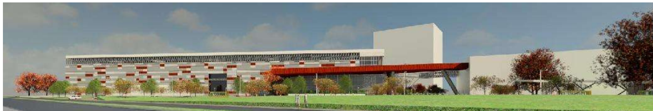
Ilustración 113. Perspectiva fachada principal del Conjunto del Centro de Convenciones y Exposiciones. Elaboración propia.
