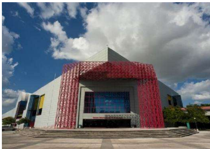
Ilustración 46. Vista exterior de CINTERMEX, marco estructural dispuesto a 45°, soportando la esquina del techo del edificio. Fuente: google imágenes.
