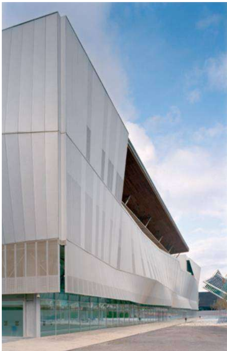
Ilustración 41. Detalle de cerramiento metálico, del centro de convenciones de Barcelona. Fuente: http://www.promateriales.com/pdf/pm1602.pdf . Fecha de consulta: (10/Nov/15).
