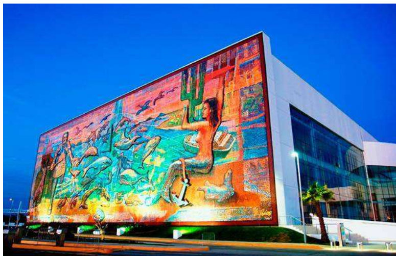
Ilustración 54. Fachada oeste obra de Ernesto Ríos, se titula “Desarrollo Histórico, Económico y Turístico del Mar de Cortés”. Fuente: http://www.portalmundoinmobiliario.com/pmi/index.php/2012-09-24-05-53-42/creportaje/disenio-arquitectonico-del-mazatlan-international-center/42-creportajes , fecha de consulta: (28/Nov/15)
