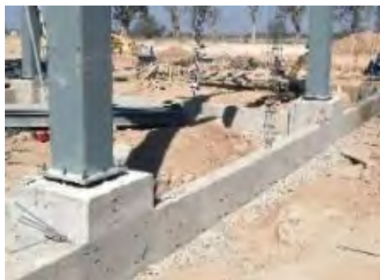
Imagen 51.- Columnas en zapatas aisladas; fuente: http://www.cuevadelcivil.com/2012/08/construccion-de-zapatas-aisladas.html .
