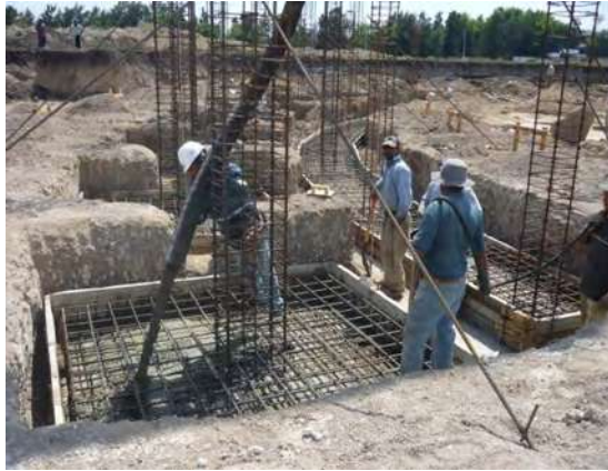
Imagen 49.- Zapata aislada en obra, fuente: http://www.cuevadelcivil.com/2012/08/construccion-de-zapatas-aisladas.html ; mayo/2016.
