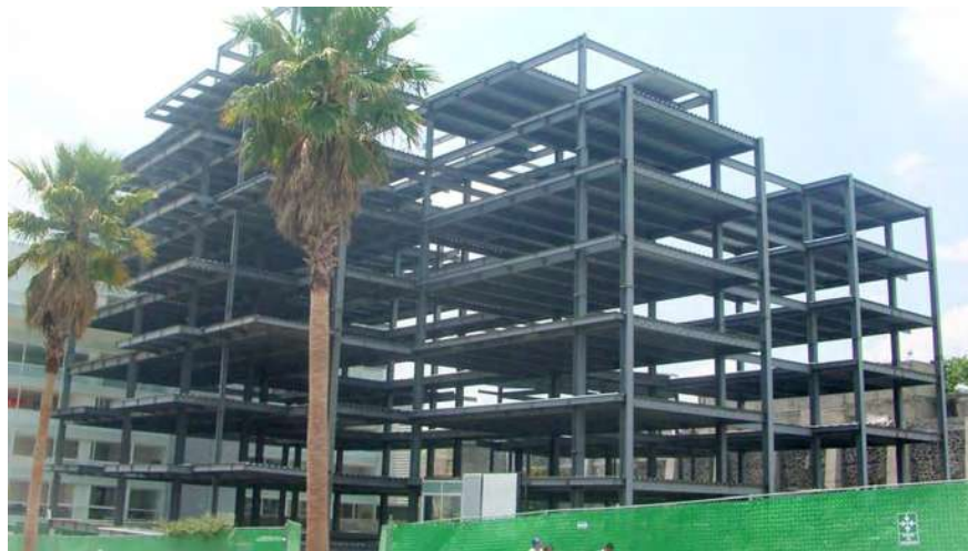
Imagen 52.-Estructura de acero, http://video.plenummedia.com.mx/suministro-y-fabricacion-de-estructuras-mexico-andamios-y-estructuras-de-acero ; Julio/2016
