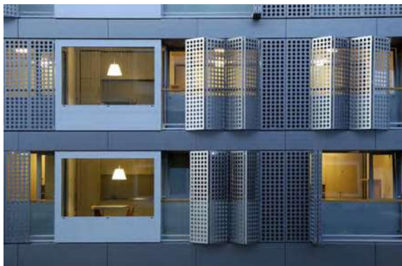
Imagen 21.- Fachada de dormitorios de vivienda estudiantil de Polijane en Liubliana, Fuente: http://www.archdaily.mx/mx/category/arquitectura-educacional/page/23 , consulta: Oct./2015
