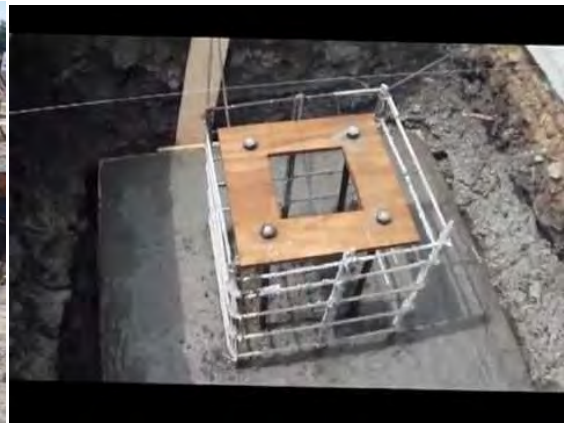
Imagen 48.- Dado para zapata aislada: fuente: https://www.youtube.com/watch?v=fSslJ_je3Sw ; mayo/2016.
