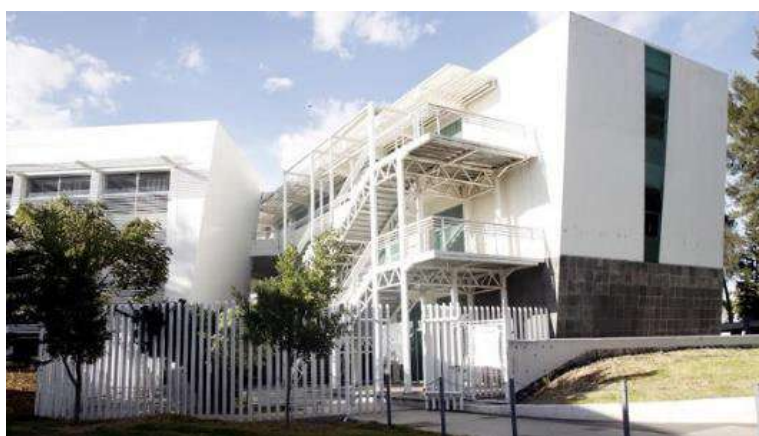
Ilustración XXXI Tipologías de construcción en Ciudad Universitaria
